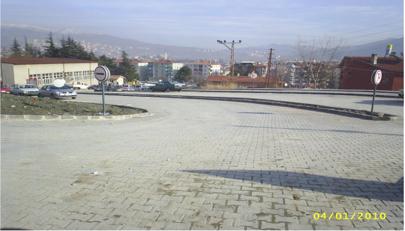
Sağlık kampüsü yol ve kaldırım çalışmaları
