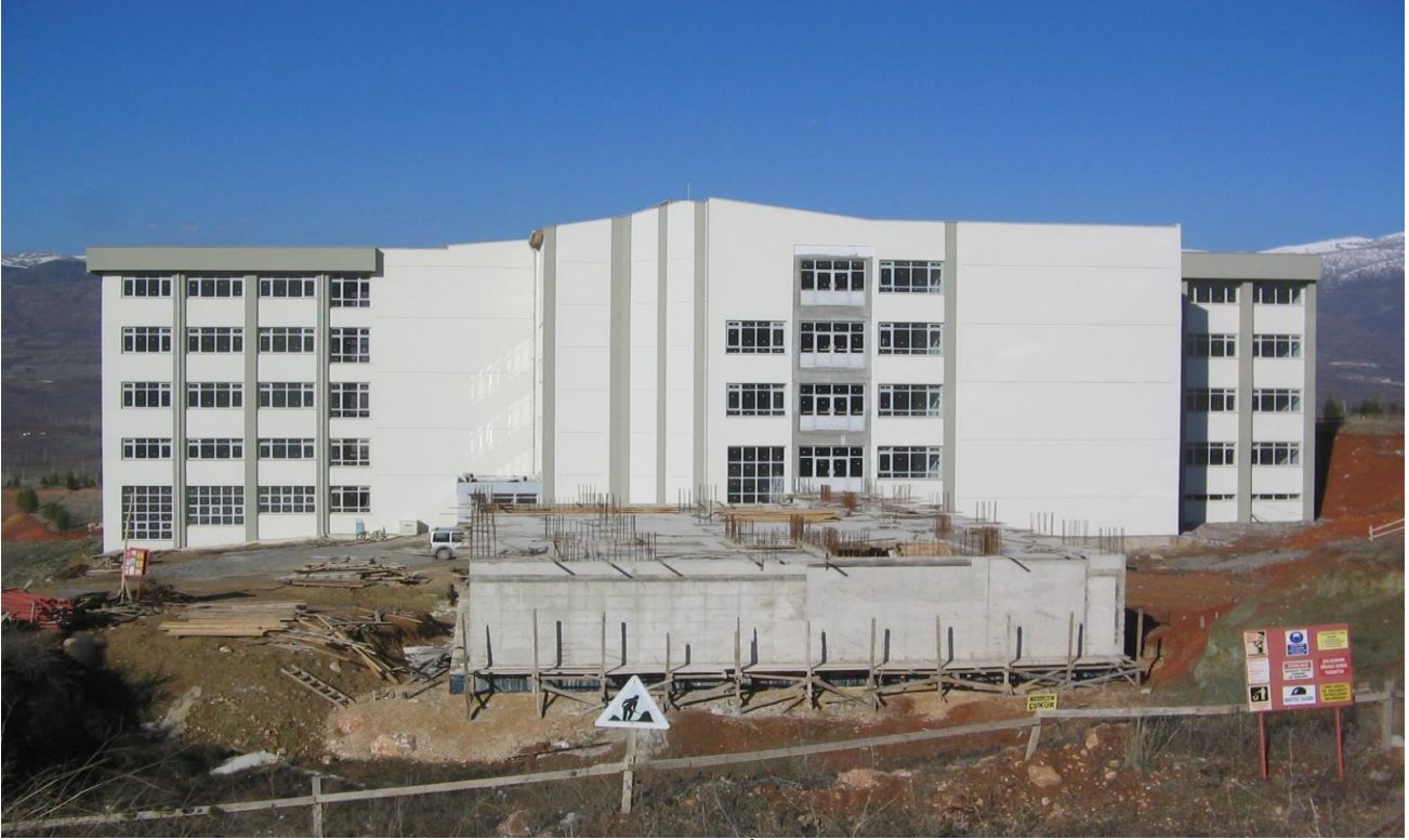
Eğitim Fakültesi Binası İnşaatı
