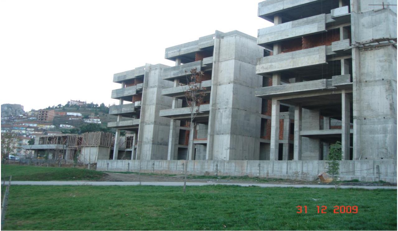
Tıp Fakültesi Morfoloji Binası İnşaatı
