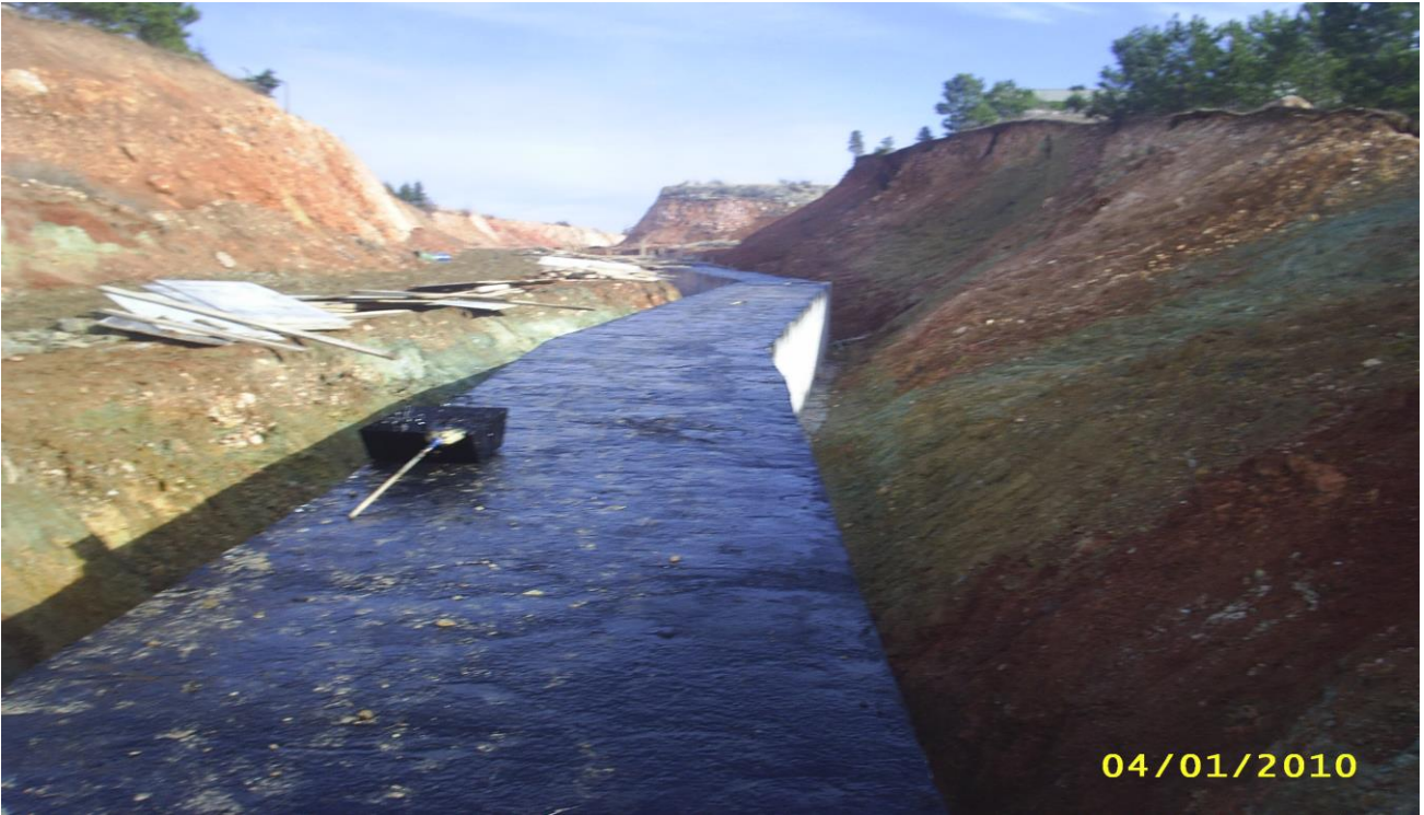
Taşlıçiftlik Kampüsü Eğitim Fakültesi Binası Isı Galerisi Betonarme İşleri
