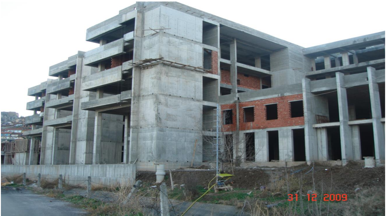
Tıp Fakültesi Morfoloji Binası İnşaatı
