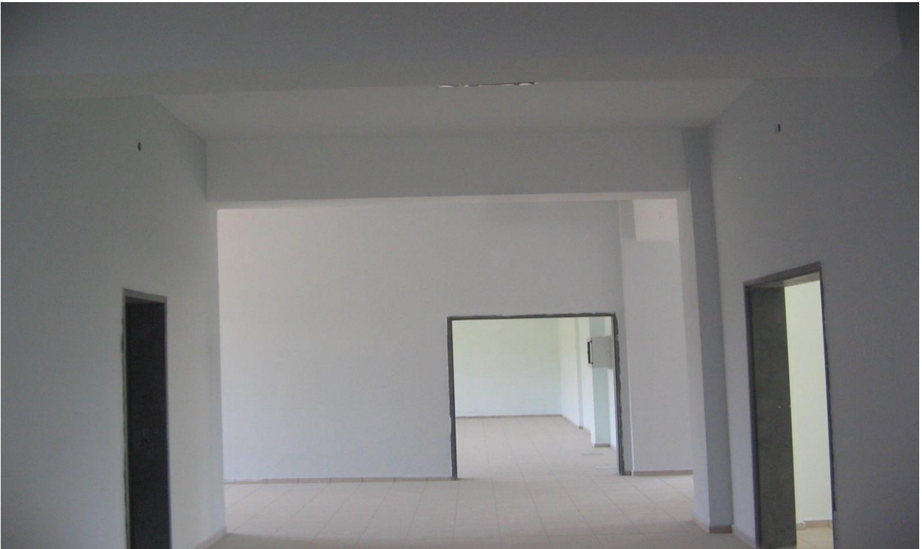
Eğitim Fakültesi Binası İnşaatı
