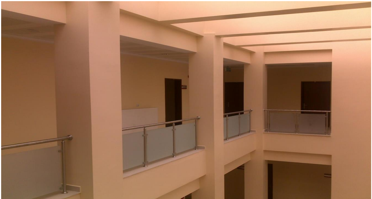
Mühendislik Fakültesi Binası
