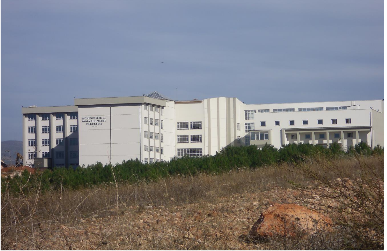
Mühendislik Fakültesi Binası
