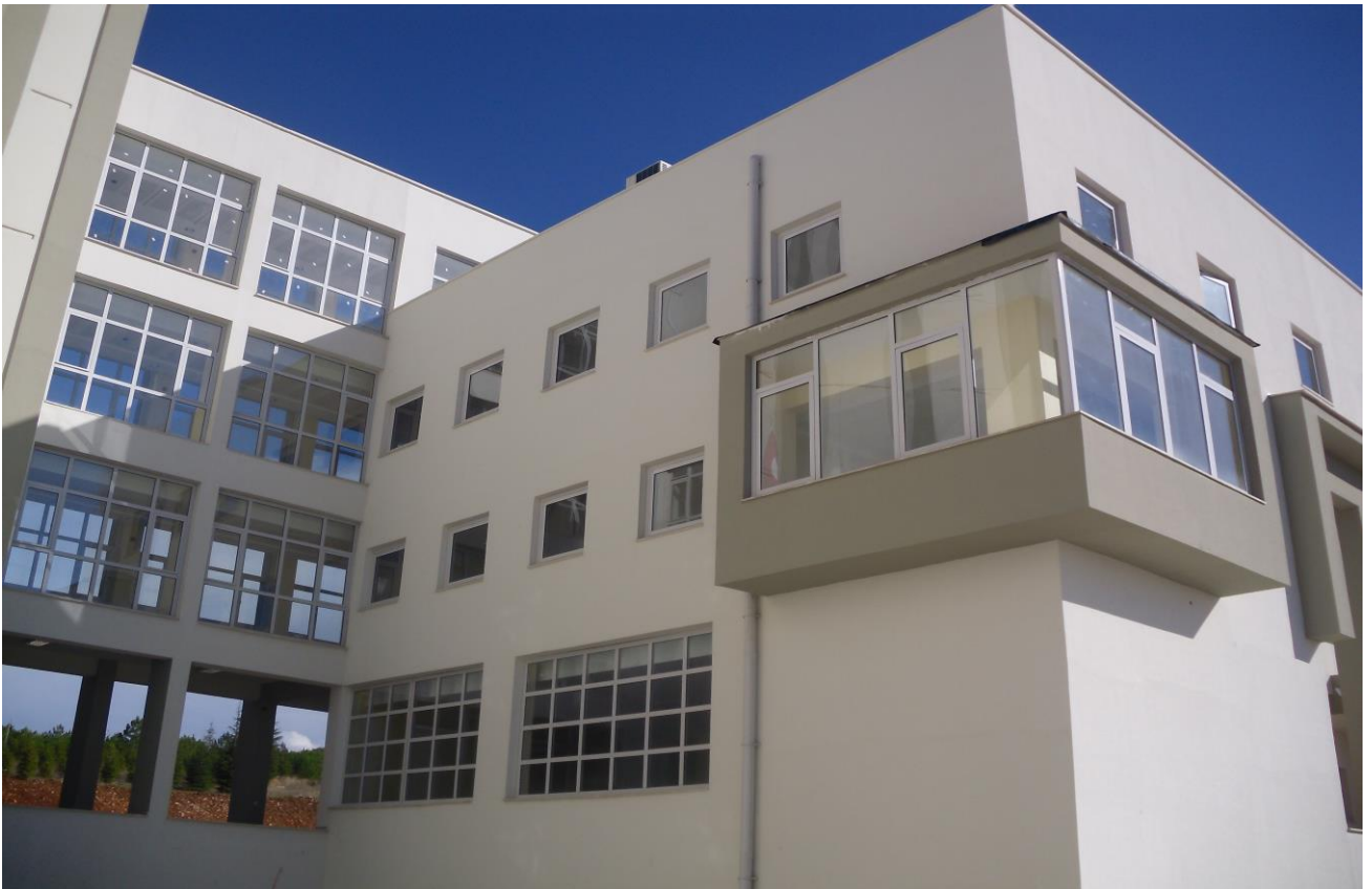
Mühendislik Fakültesi Binası
