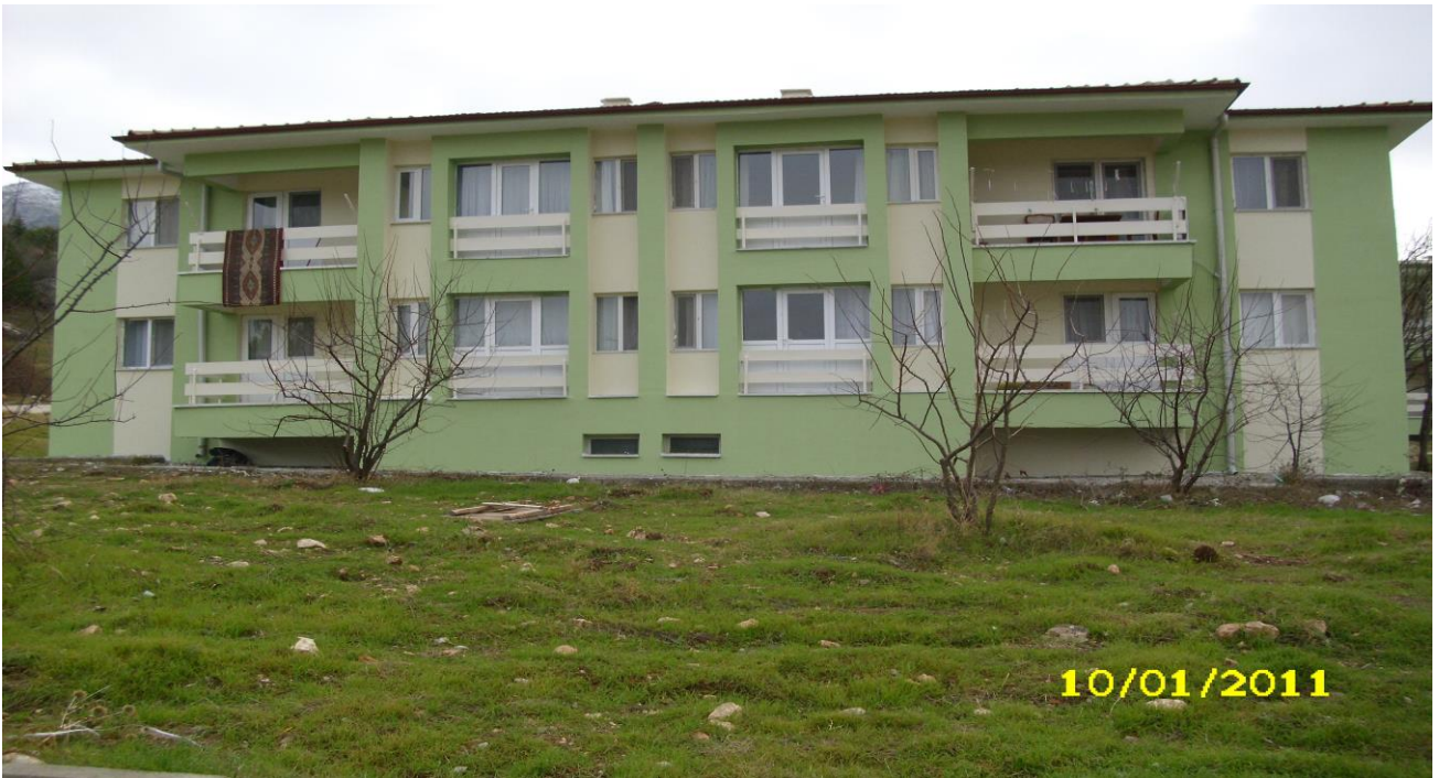
Taşlıçiftlik Kampus Lojmanları Dış Cephe Isı Yalıtımı (Mantolama) Doğalgaz Dönüşümü ve Boya işleri
