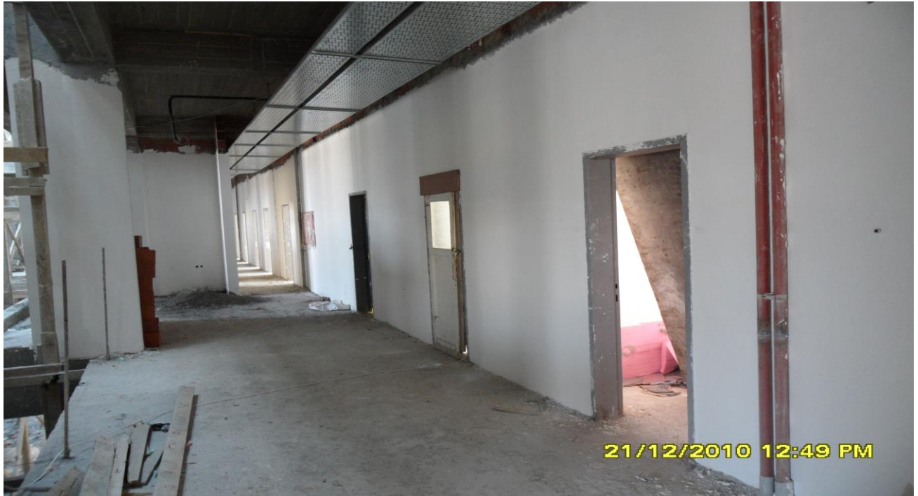
Tıp Fakültesi Morfoloji Binası İnşaatı
