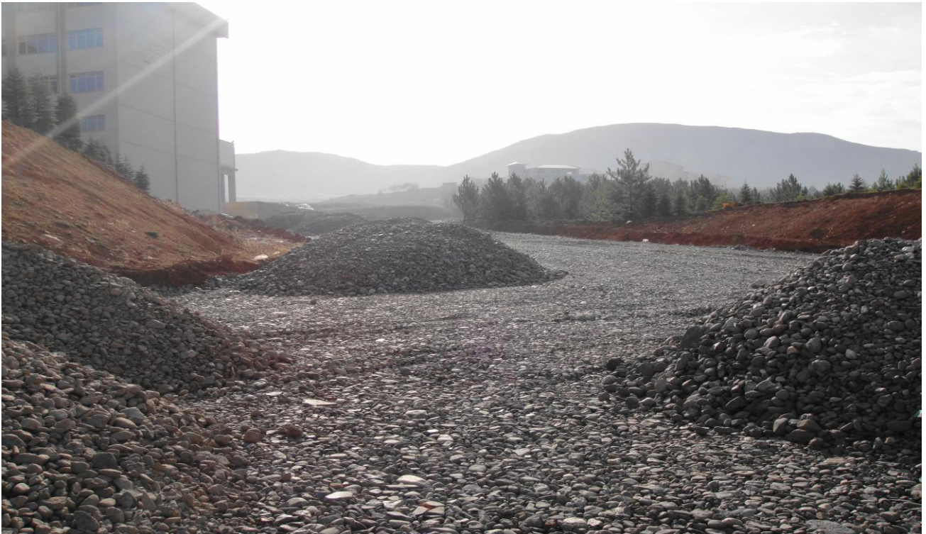
Mühendislik Fakültesi Binası Yol çalışmaları
