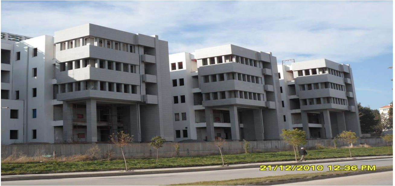
Tıp Fakültesi Morfoloji Binası İnşaatı
