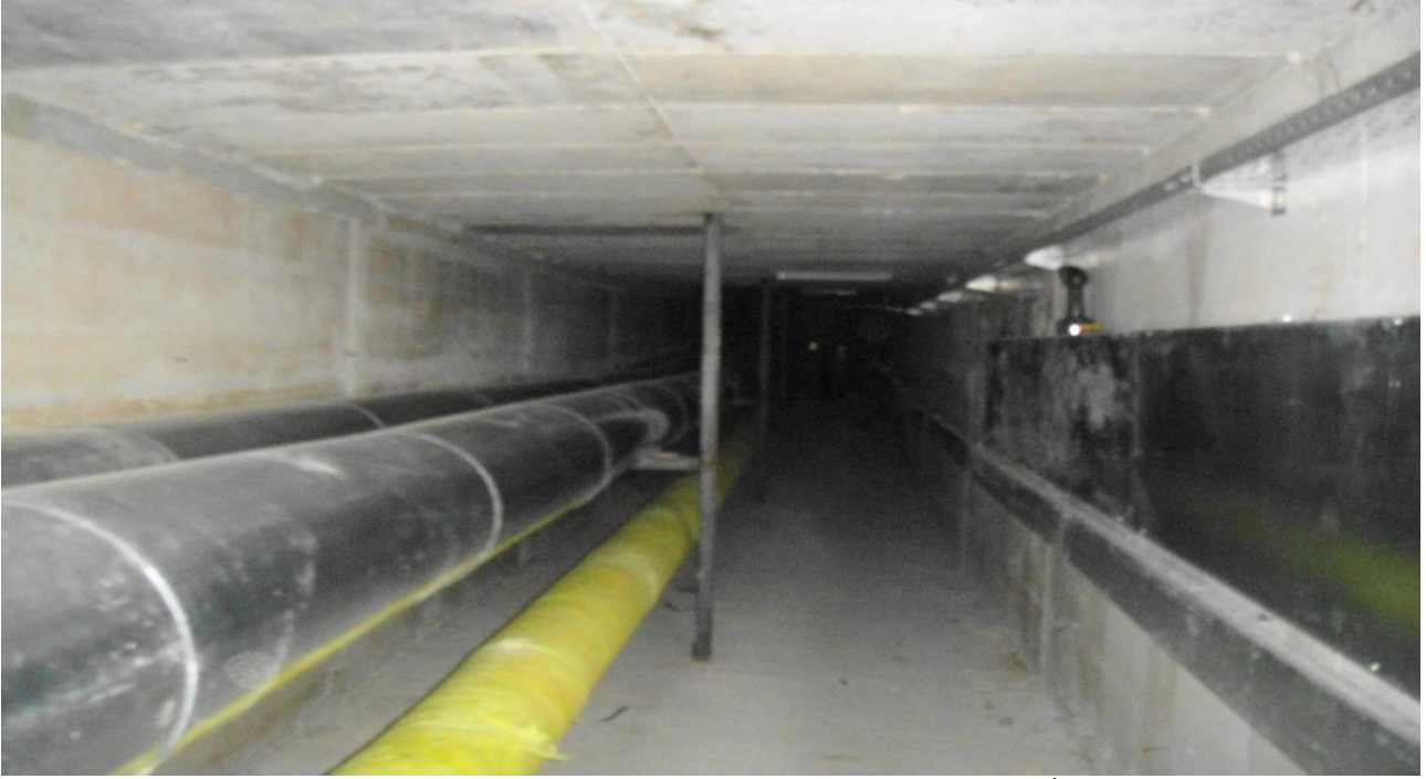
Mühendislik Fakültesi Galeri Hattı Mekanik Tesisat İşleri
