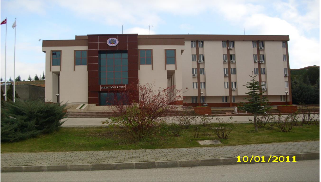
Rektörlük Binası Dış Cephe Isı Yalıtımı (Mantolama) ve Boya İşleri
