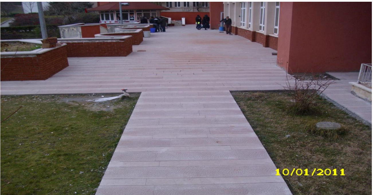
Ziraat Fakültesi Bahçesi Andezit Kaplama İşleri
