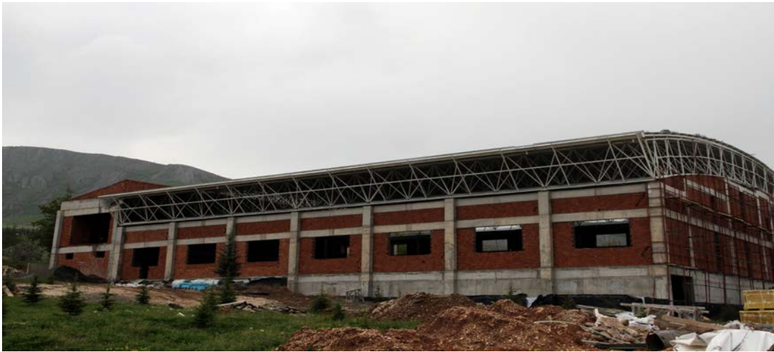
Kapalı Yüzme Havuzu İnşaatı
