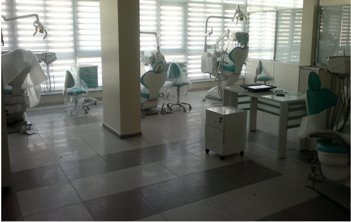
Diş Hekimliği Fakültesi Binası Tadilat ve Onarımı
