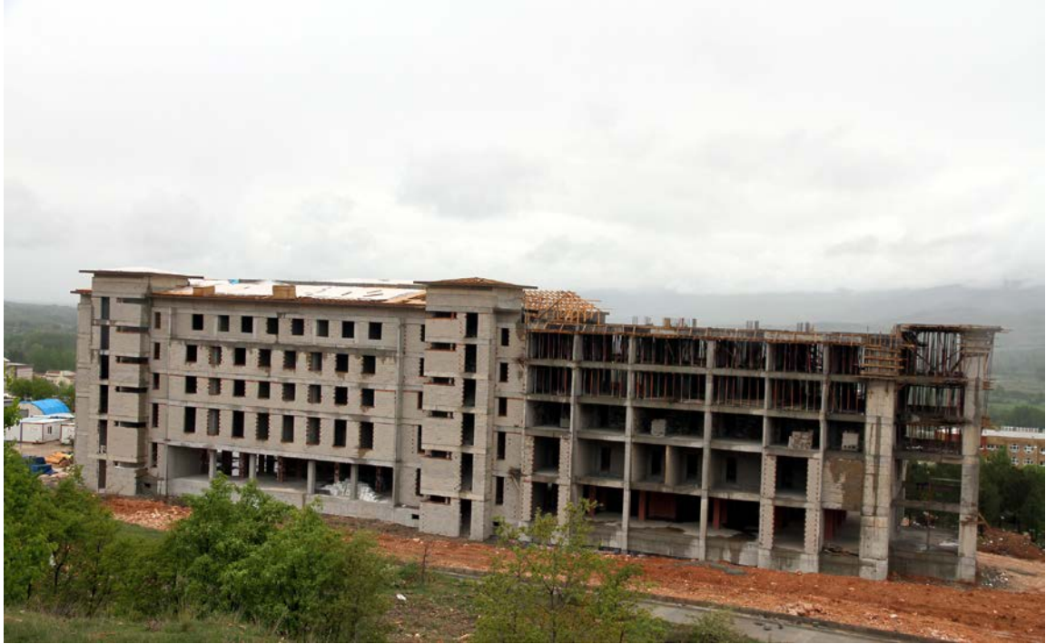
Eğitim Fakültesi Binası İnşaatı
