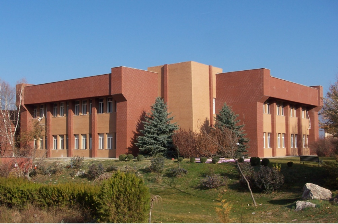
Ziraat Fakültesi Binası Dış Cephe Isı Yalıtımı
