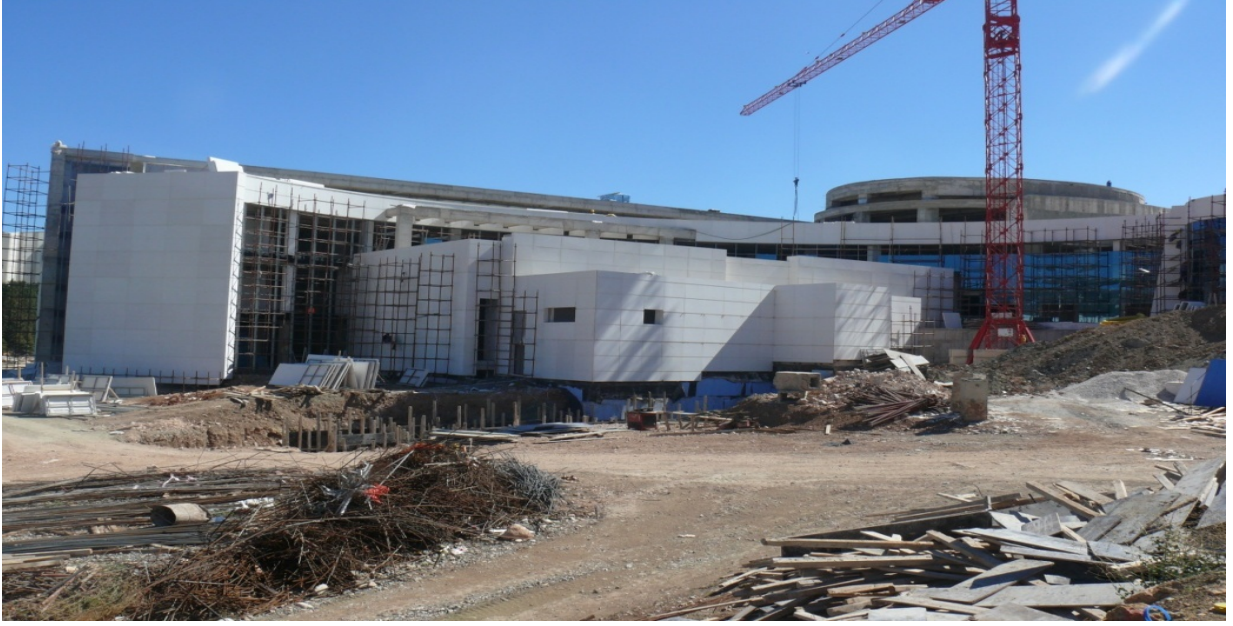
Ortak Derslik Binası
