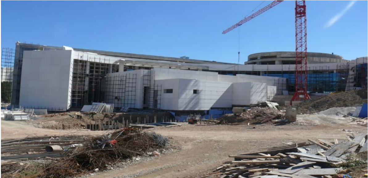
Ortak Derslik Bina İnşaatı
