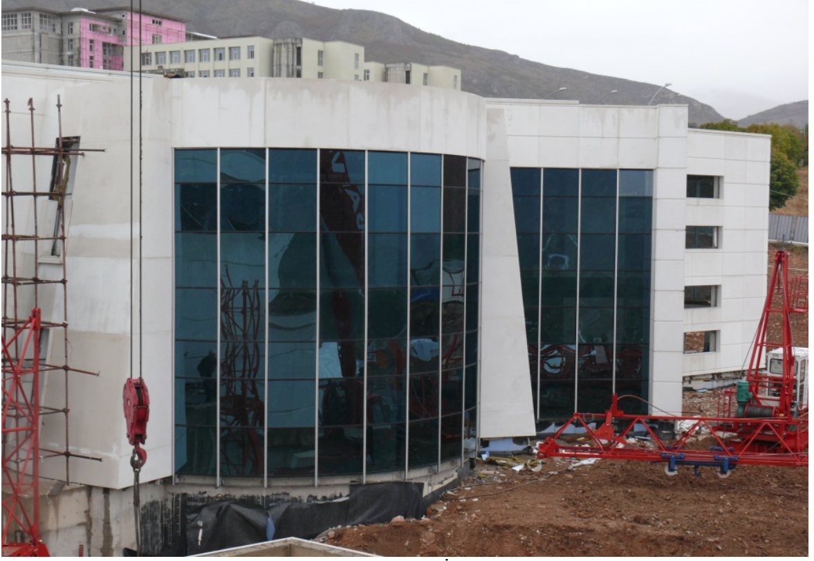
Ortak Derslik Bina İnşaatı
