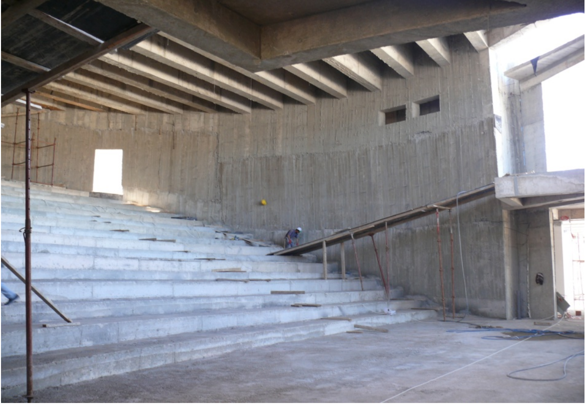
Ortak Derslik Bina İnşaatı
