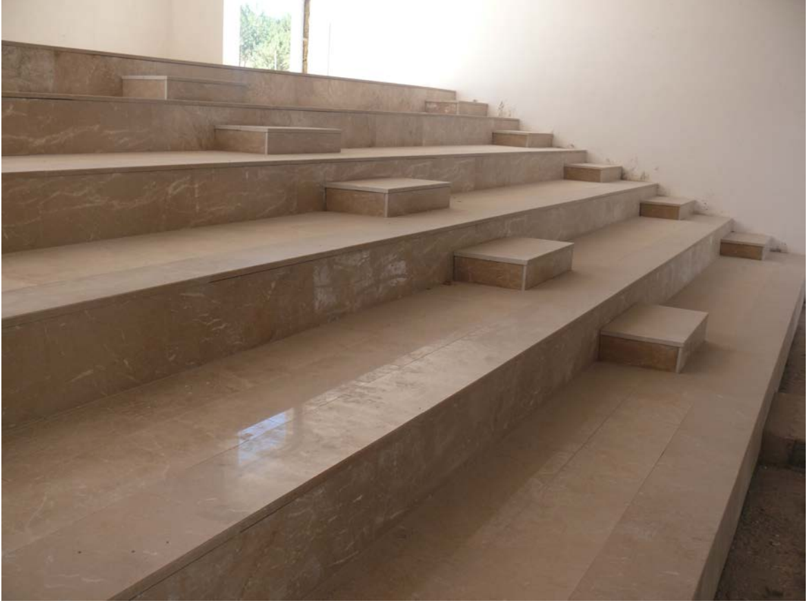
Ortak Derslik Bina İnşaatı
