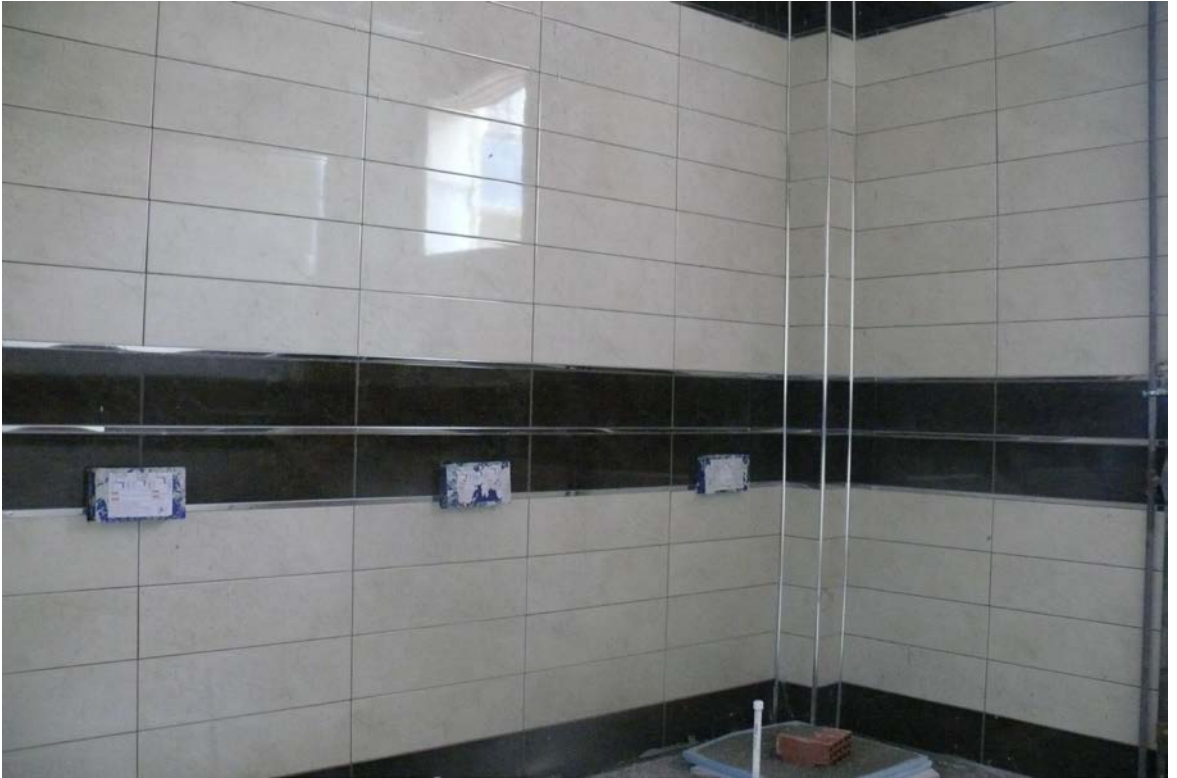
Ortak Derslik Bina İnşaatı
