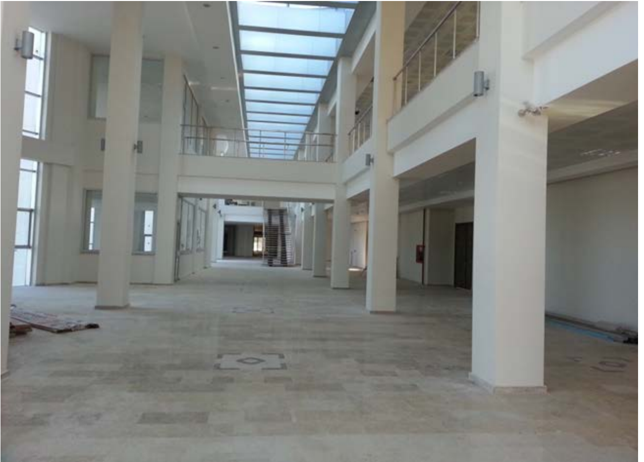
Ortak Derslik Bina İnşaatı
