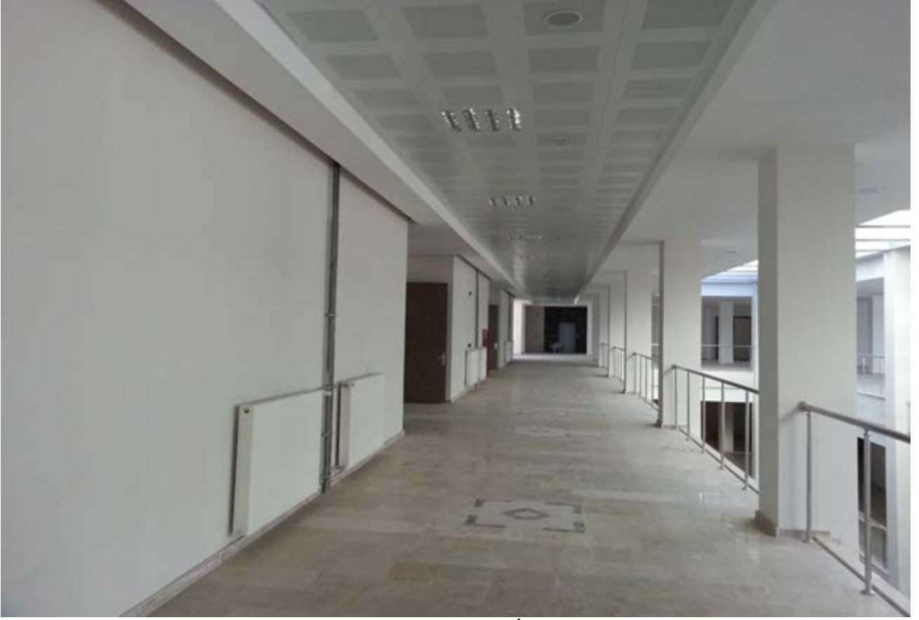
Ortak Derslik Bina İnşaatı
