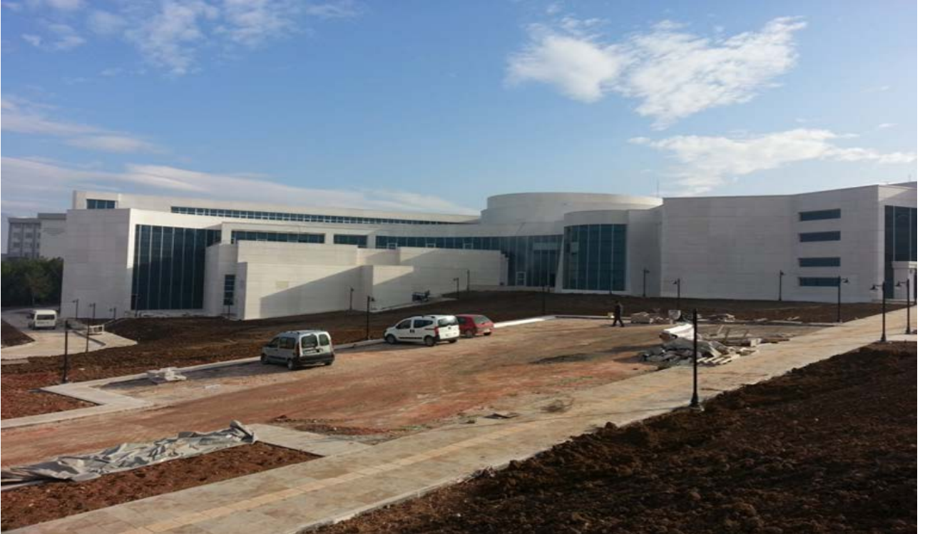
Ortak Derslik Bina İnşaatı
