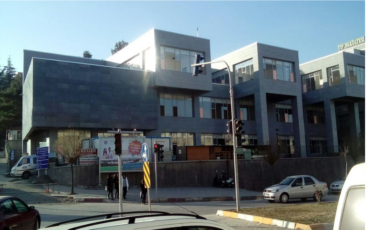
Tıp Fakültesi Merkezi Derslik Binası
